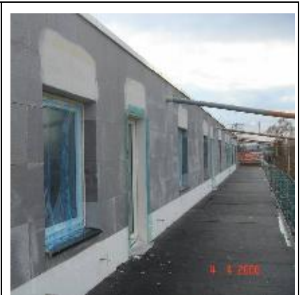
6. Dämmung DG
