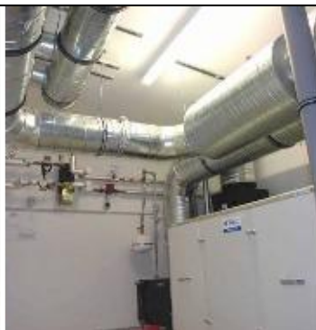
5. zentrale Lüftungsanlage
