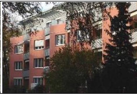
2. Ansicht Saniert Balkonseite
