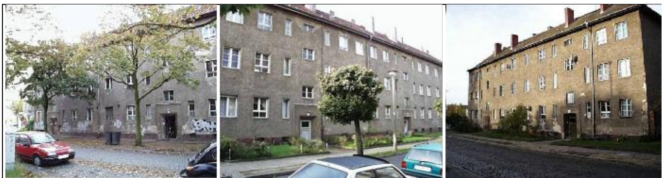
1. Voltastrasse Fassade Südost
