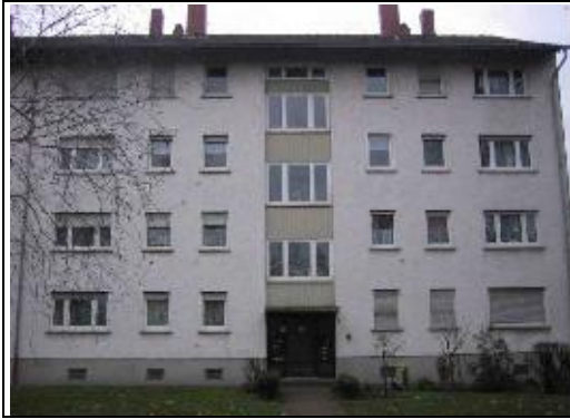
1. Ansicht Eingangsseite, Hirtenweg 8-18
