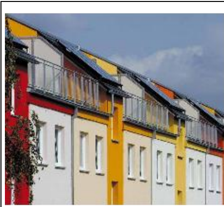
4. Sanierung: Fassade Hauseing.
