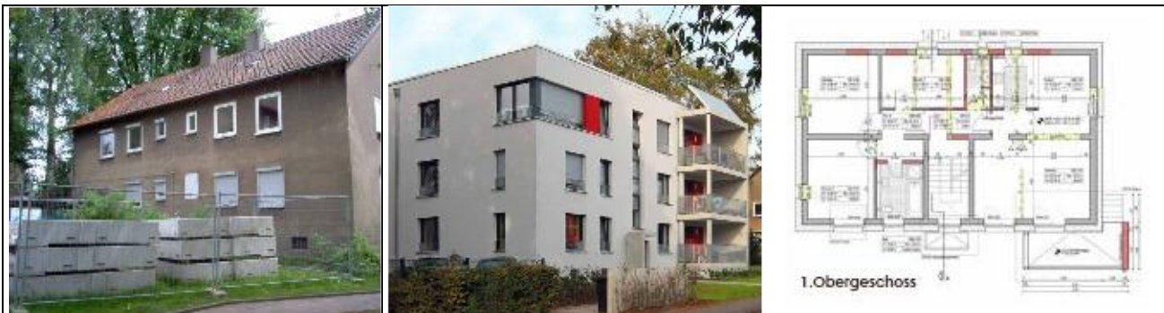
1. Im Hole vor Sanierung
