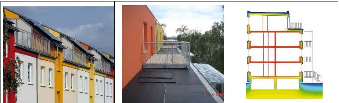
4. Sanierung: Fassade Hauseing.
