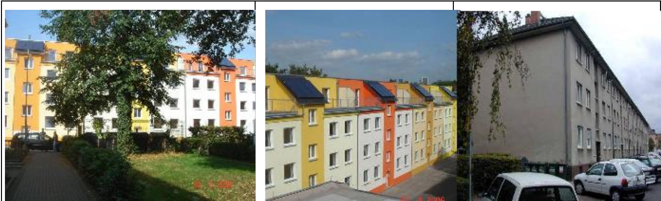
1. Ansicht Straßenseite Tevesstraße 36 - 46
